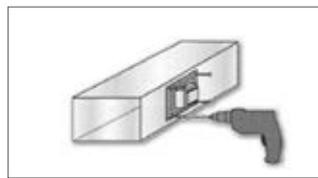
6. Tagliare con un seghetto alternativo o una forbice idonea, la porzione di canale tracciata, rimuovere eventuali sbavature taglienti. Posizionare il dispositivo BioxAir sul lato del condotto d'aria e avvitare.
